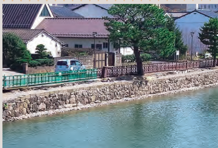
史跡松江城東内堀石垣保存修理
